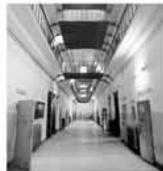
EX CARCERE DELLE MURATE. PARTICOLARE DEL CORRIDOIO PRINCIPALE DELLA ZONA DI DETENZIONE
